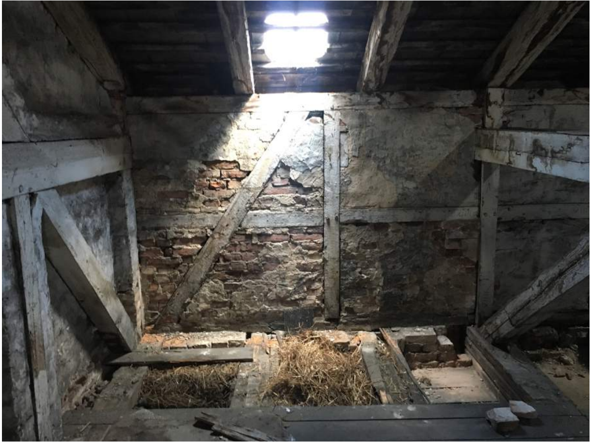
51) Kniestock mit erheblichen Witterungsschäden, 9. Mai 2017 (Foto Autor)
