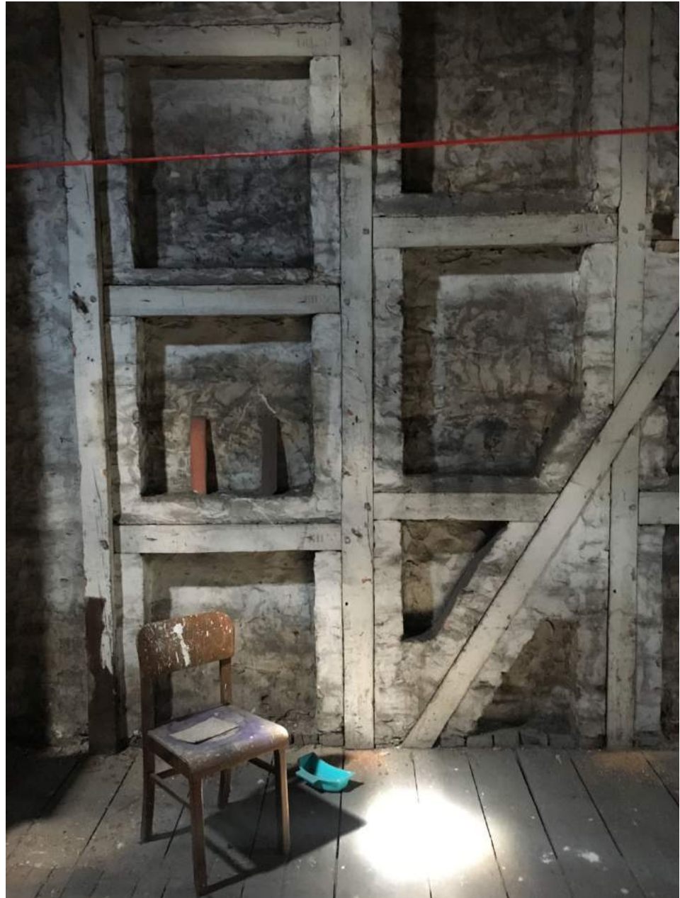
Dachboden des Hauses Schöneberger Ufer 57, 9. Mai 2017 (Foto Autor)
