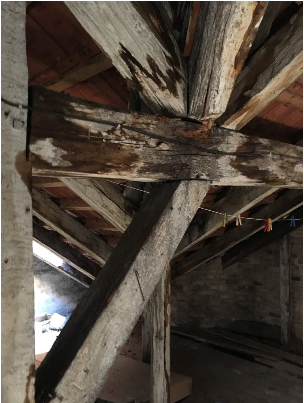
50) Dachstuhl von 1860 mit erheblichen Schäden durch Schwamm- und Schimmelbefall, 9. Mai 2017 (Foto Autor)
