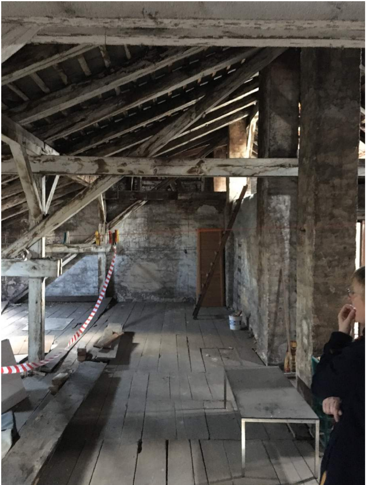
49) Dachboden des Vorderhauses Schöneberger Ufer 57. Blick nach Osten, 9. Mai 2017 (Foto Autor)
