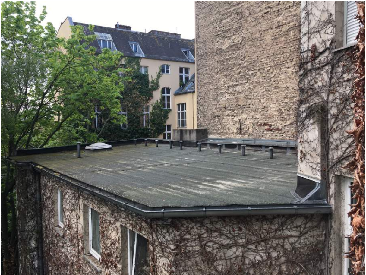
47) Notdach des Seitenflügels Schöneberger Ufer 57, 9. Mai 2017 (Foto Autor)
