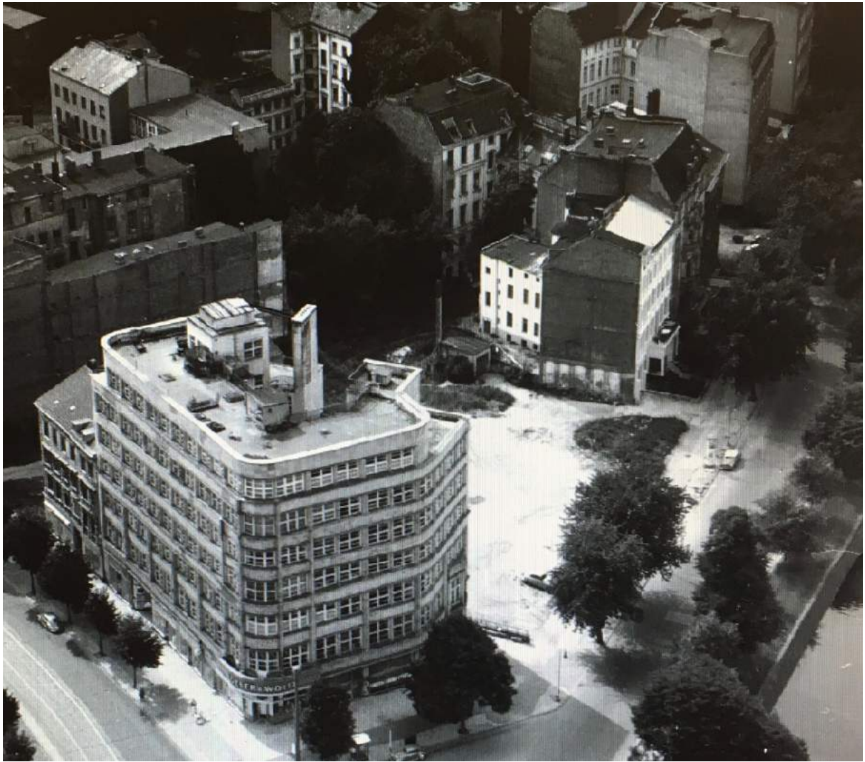
32) Blick aus der Luft über die Häuser am Schöneberger Ufer (zu sehen ist die Brandwand der Nr. 57) Ecke Potsdamer Straße, 1960 (LAB, F Rep. 290-02, Nr. 308190)
